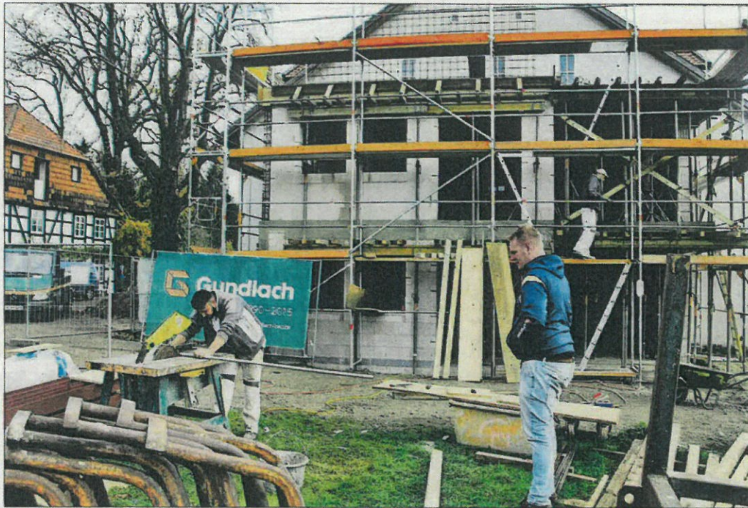
Handwerker bauen das frühere Bettenhaus des Eichenhof-Hotels um. Bislang wohnen Jugendliche im benachbarten Fachwerkhause (links).
